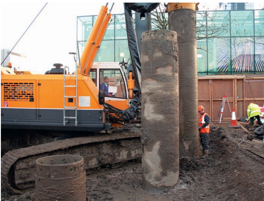
Eindreihen von Bohrrohren (London) installing casings (London)
